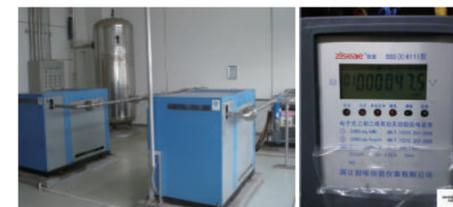
寶健（中國）日用品有限公司兩臺 22KW 空壓機使用星三角起動，每天耗電量在 300-350 度，同樣的工况下，使用空壓機節能驅動一體機改造以後，耗電量在 200-248 度，每日節約 50-100 度電，按 3RMB/度電，每日節約 44RMB-88RMB，按平均節約 60RMB/天計算，一個月節約電費約 1800RMB，一年節約電費約 21600RMB。
